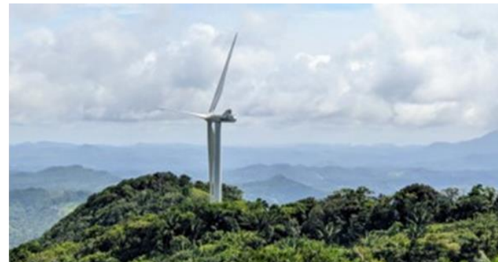
Parque eólico Toabré (Panamá) 66 MW
