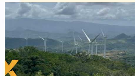
Parque eólico Toabré (Panamá) 66 MW
