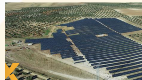
PV El Toconal (Toledo) 5 MWp
