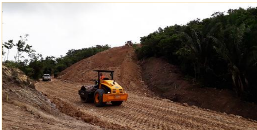
Obras de construcción en Panamá
