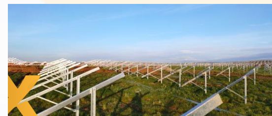
Construcción plantas fotovoltaicas Zarzuela I, II, III y IV en Toledo
