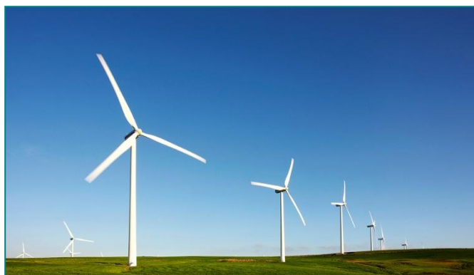
The Hinojal Wind Farm
