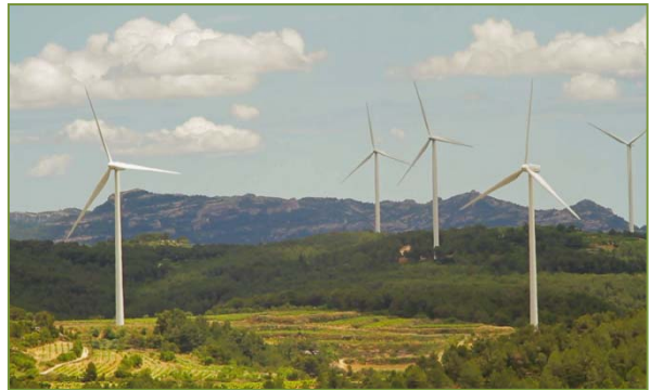
The Hinojal Wind Farm
