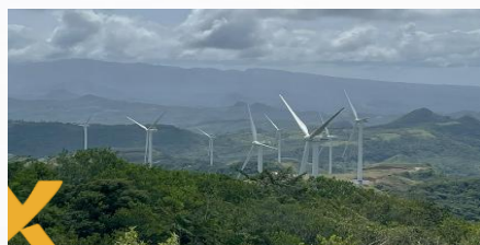
Wind farm Toabré (Panamá) 66 MW
