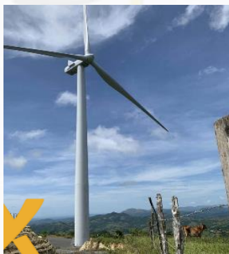
Wind farm Toabré (Panamá) 66 MW
